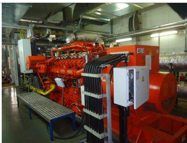
Помещение энергоцетра с установленными газогенераторными установками Ecopower AGP1000
