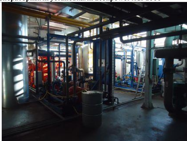
Помещение энергоцетра с установленными газогенераторными установками Ecopower AGP1000
