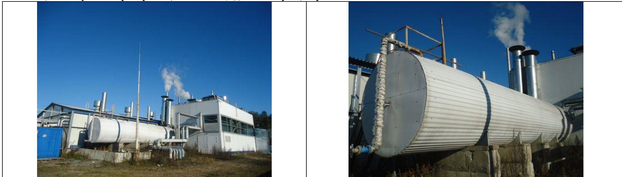
Общий вид энергоцентра. Основной корпус 1 очереди (за цистерной) и пристройка
