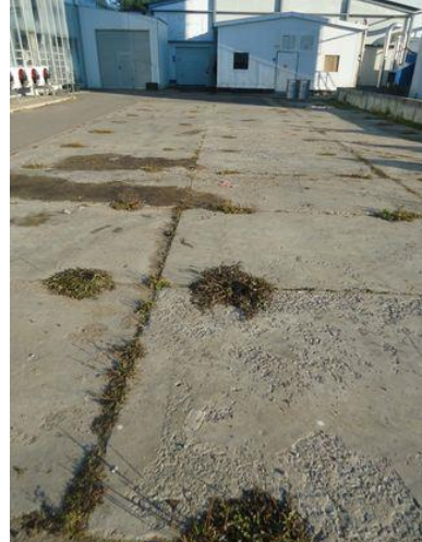
№ п/п 37, инв. № 15, Производственная площадка из дорожных плит, замощение территории 290 м.кв.
