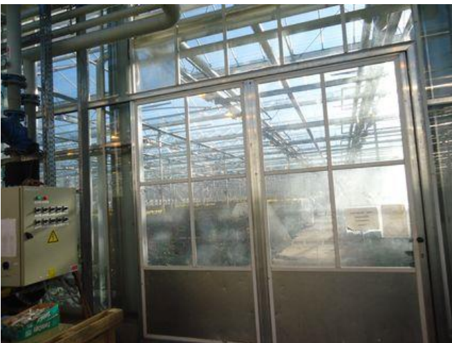
№ п/п 6, инв. № 11, Ворота откатные, между 1-ой и 2-ой очередью теплиц
