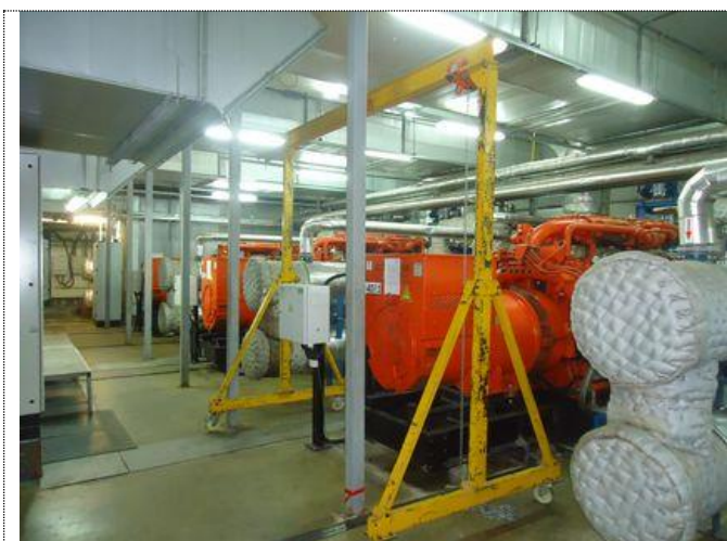
Помещение энергоцетра с установленными газогенераторными установками Ecopower AGP1000
