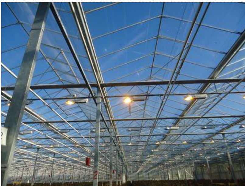
Системы досветки и вентиляции
