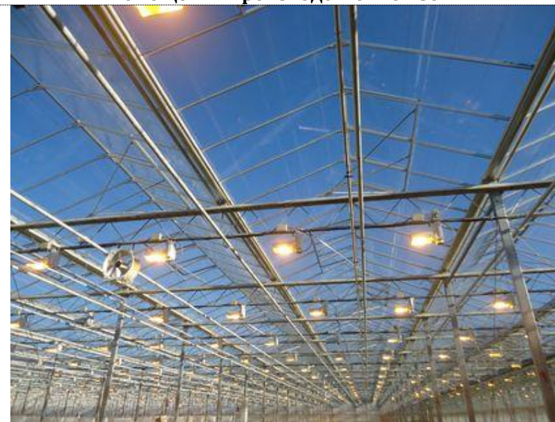
Системы досветки и вентиляции
