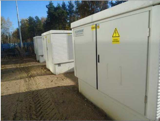
№ п/п 60, инв. № 64, Электрические сети и установки наружные. - кабельные сети и три повышающих трансформатора для отпуска эл.энергии сторонним потребителям
