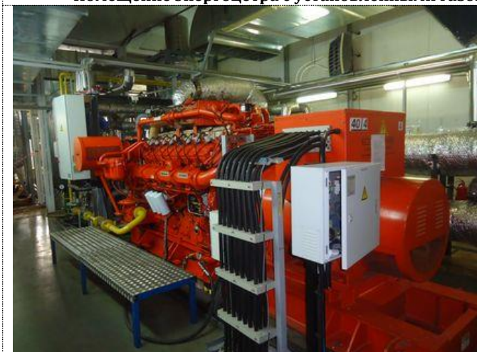
Помещение энергоцетра с установленными газогенераторными установками Ecopower AGP1000
