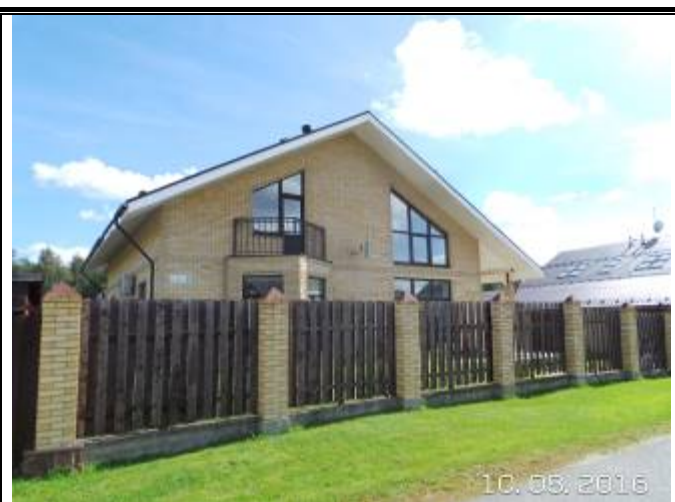
2. Внешний вид жилого дома и земельного участка
