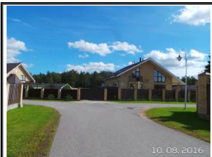
1. Внешний вид жилого дома и земельного участка
